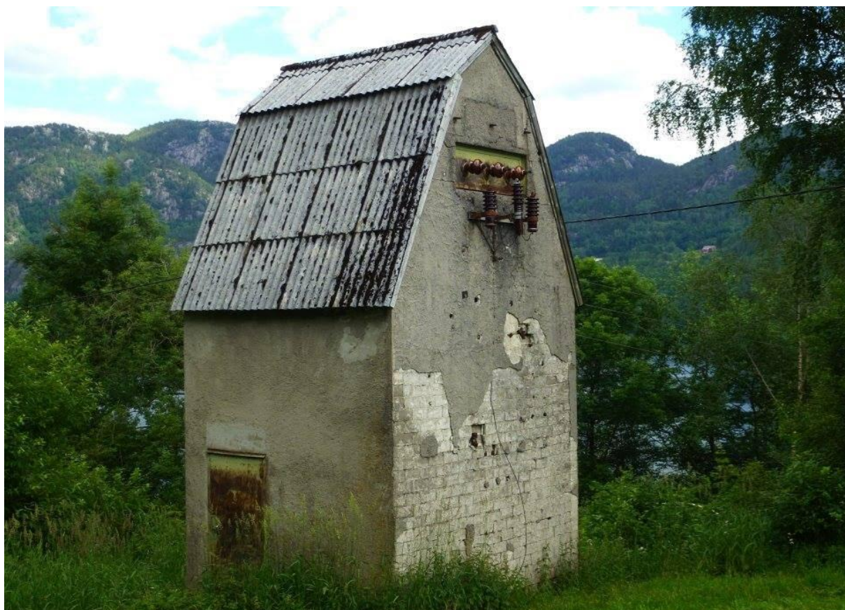
Foto : Trafokiosk til Sandsmarksgruver / fotograf Frans-Arne Stylegar - Multiconsult
