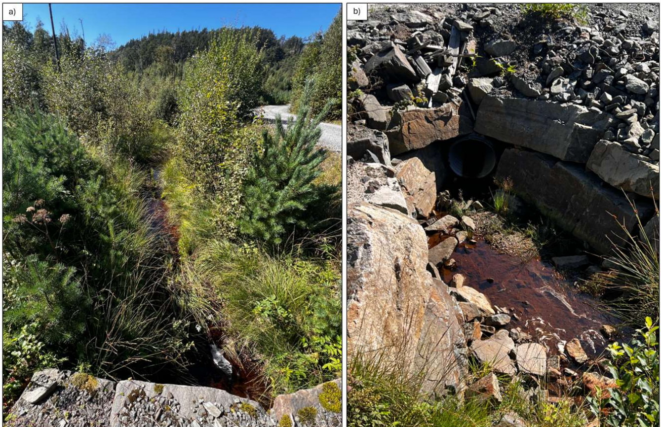
Figur 11 Bildene viser a) bekkeløp nordøst for og oppstrøms av kartleggingsområdet og b) inntak til drenering under etablert deponi. Bekken føres under deponiet med plastrør med diameter på 60 cm. Ut fra tilgjengelige flomverdier vurderes etablert rør til å ta unna for selv ekstreme flomhendelser. Bildelokasjoner er avmerket med henholdsvis 4 og 5 i Figur 6. Bilde av Skrið
