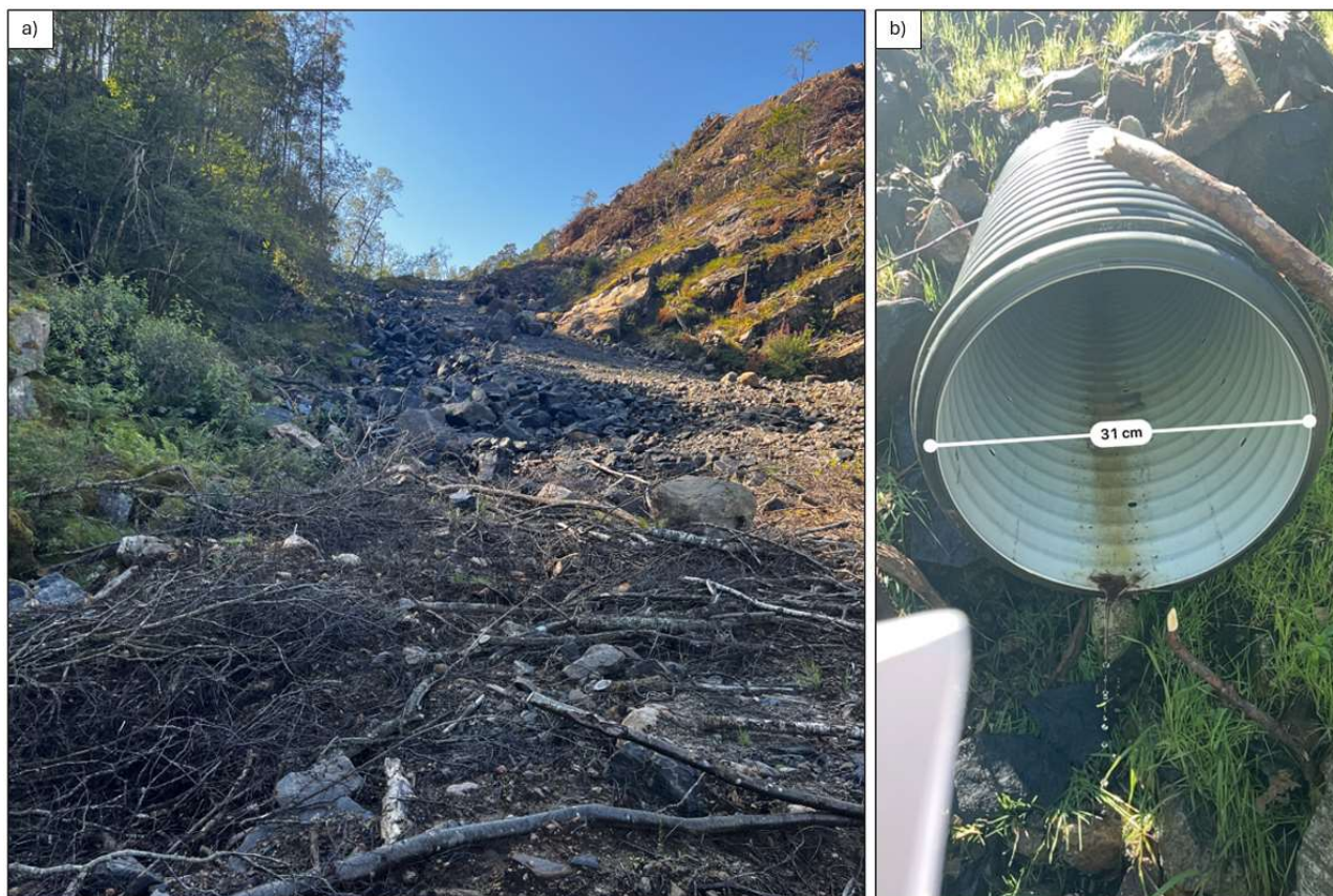
Figur 14 Bildene viser a) utfylling sentralt i kartleggingsområdet og b) rør etablert for drenering av bekk / vassig. Bildelokasjoner er avmerket med henholdsvis 9 og 10 i Figur 6. Bilde av Skrið.
