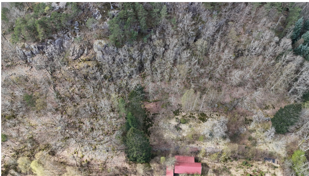
Figur 0-4: Oversiktsfoto drone. Viser brattskrentar og underliggende terreng. Eksisterende bygg som referansepunkt.
