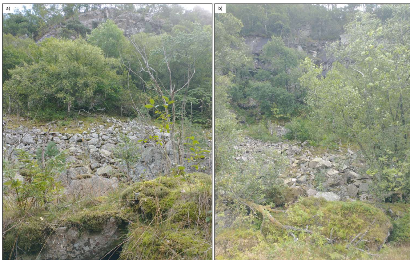
Figur 26 Bildene viser steinur i underkant av Knaben som stedvis strekker seg inn i østlig del av kartleggingsområdet. Kartlagt ur fremstår stabil uten tegn til nyere utfall. Bildelokasjoner er avmerket med henholdsvis 4 og 5 i Figur 21. Bilde av Skrið.
