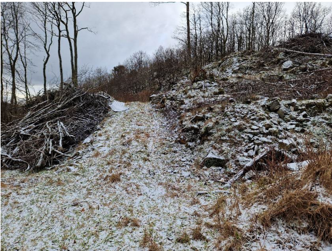
FIGUR 5: BILDE FRA BEFARING
