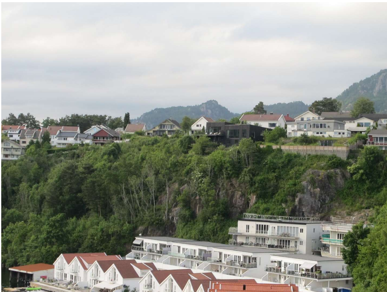
Figur 9: Fargeeksempel på matt svart hentet fra referansebygg på Uenes. Kilde: Frode Jerdal, KSO
