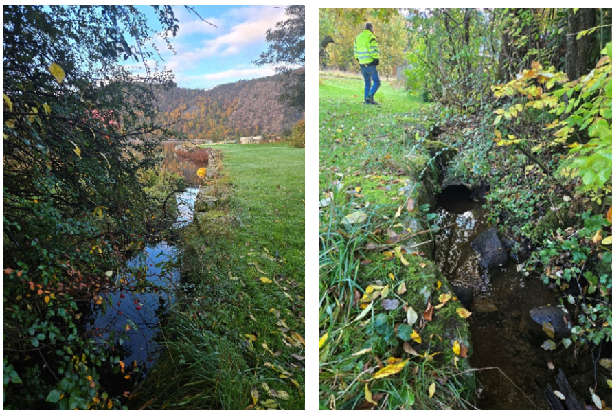
Figur 7: Bilder fra befaring. Bilde til venstre viser forsenkning i terrenget ved Nereid. Bilde til høyre viser kulverten ved Nereid.
