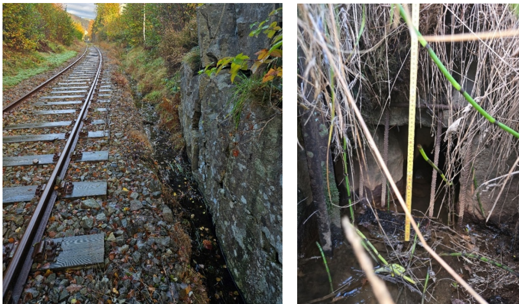
Figur 6: Bilder fra befaring. Venstre bilde viser renne langs jernbane. Høyre bilde viser kulverten ved Nereid.
