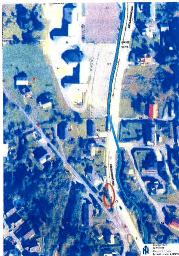
Farlig mur/fjellparti ved Søyland skole
