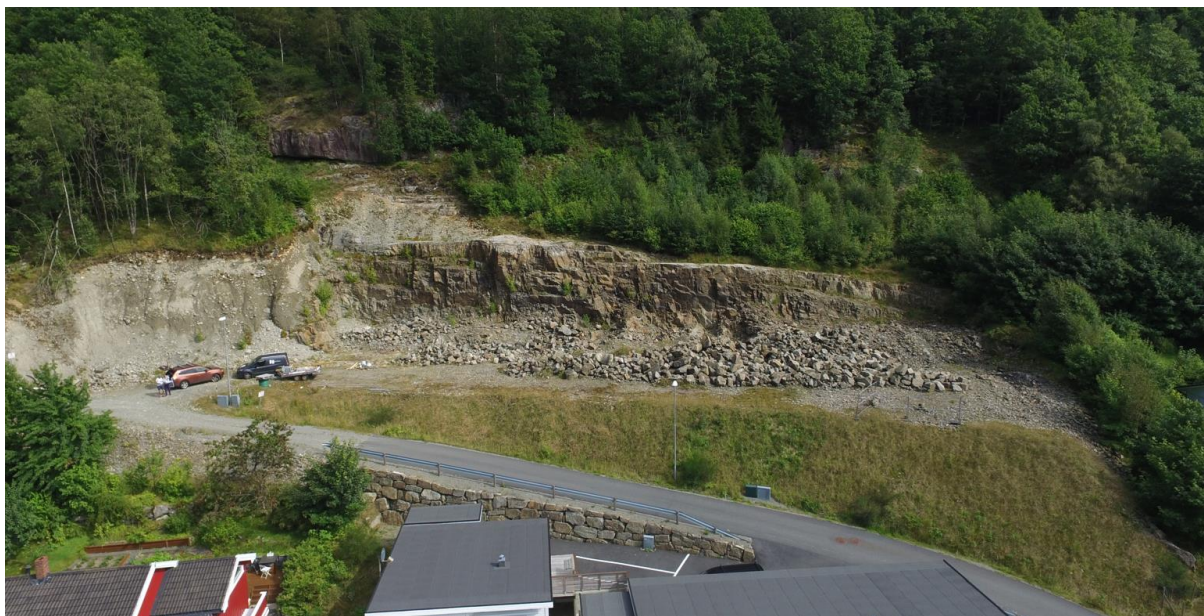
Figur 12: Dagens arealbruk av planområdet. Bilde er av byggeområde B8, tatt fra vest mot øst. Her ser man adkomstvegen er opparbeidet et stykke opp mot planområdet.
