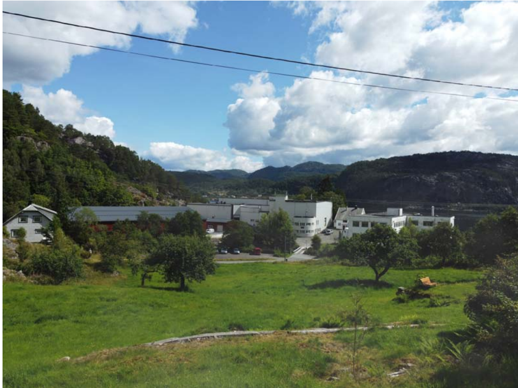
Nåsituasjon sett fra Gardsveien:
