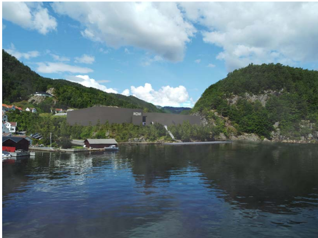
Etter utbygging, sett fra fjorden:
